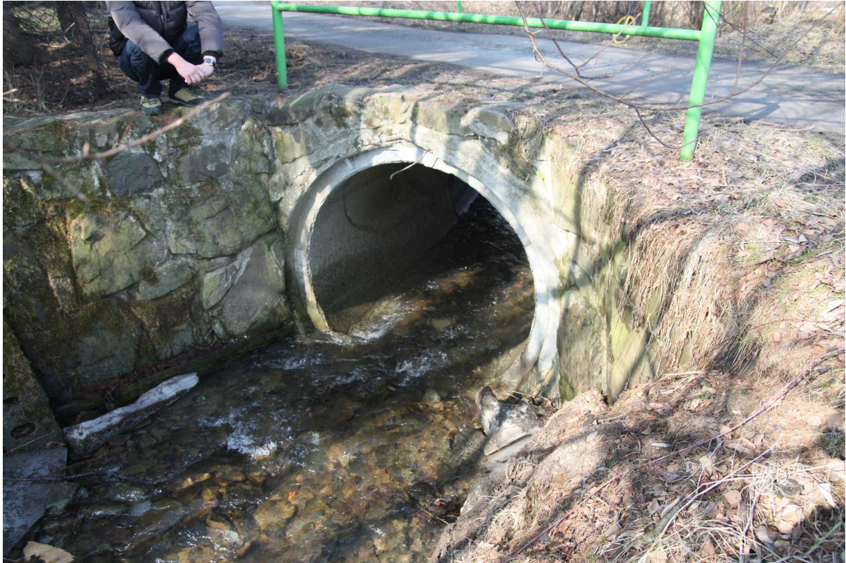
Ścianka czołowa na wlocie do przepustu
