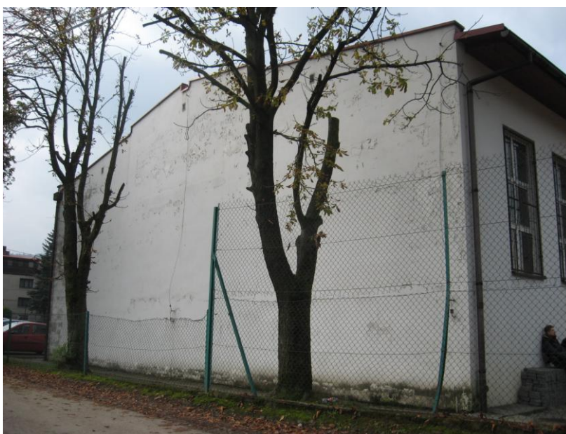
Fot. 4 Elewacja wschodnia
