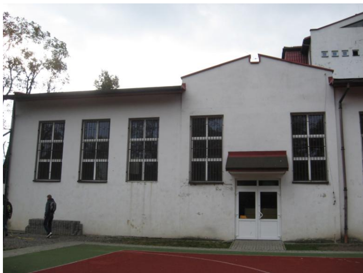
Fot. 1 Elewacja północna
