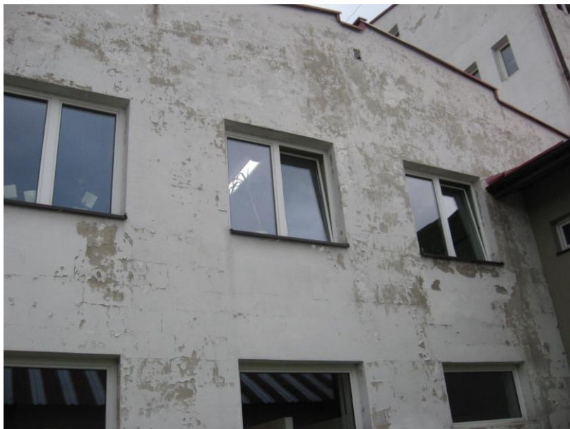
Fot. 3 Elewacja zachodnia
