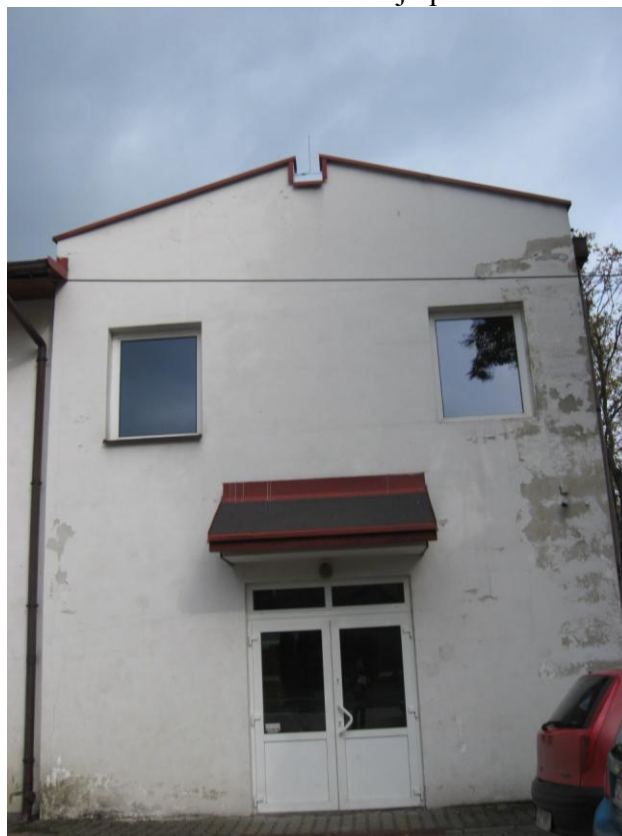
Fot. 2 Elewacja południowa
