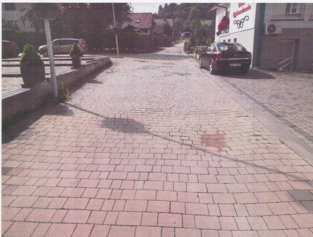
Rynek w Ślemieniu kostka brukowa betonowa ( kolorowa )
