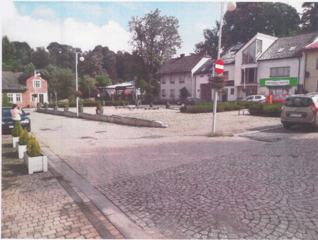
Rynek w Ślemieniu – widok lamp, wzmocnienie szczydła ( wypionowanie )
